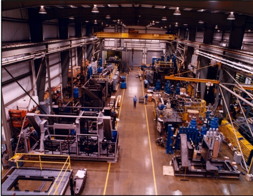
40 Ton Bridge Crane
